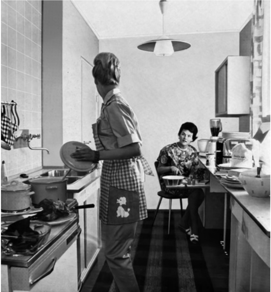
11. Quelle-Fertighaus, Einblick in die Küche mit Wandversprung im Bereich des Heizungsschachts
