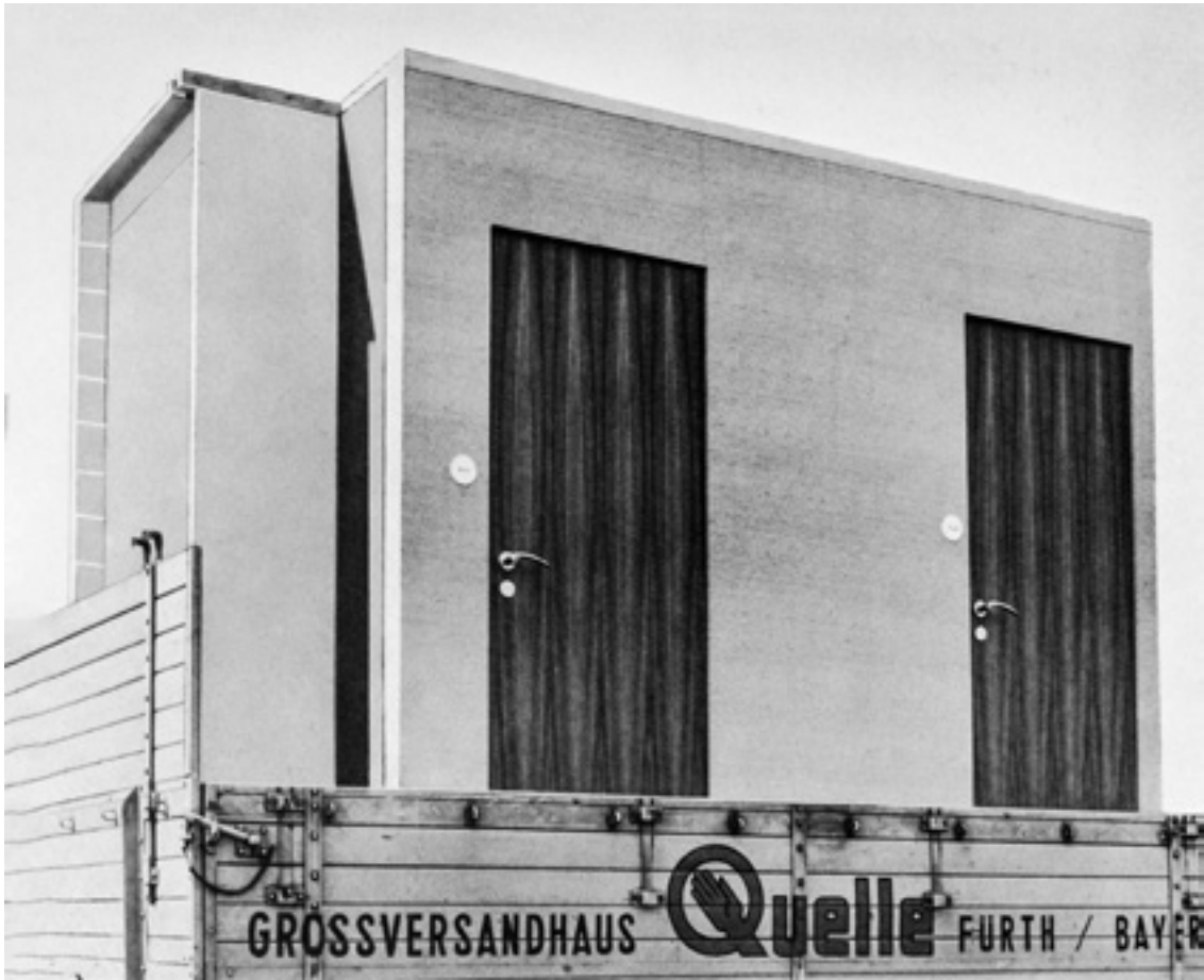
10. Quelle-Fertighaus, vorgefertigter Sanitärkern auf dem LKW
