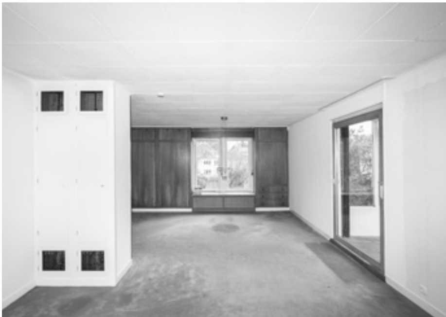
16. Essen-Werden, M.A.N.-Stahlhaus, Wohnzimmer mit Einbauschränken und Heizkörpern in Einbauschränken (weiße Schränke im Vordergrund, unterscheidbar anhand der Auslassgitter), kassettierter Decke aus Faserzementplatten und Wandbeplankung aus Holzwerkstoffplatten
