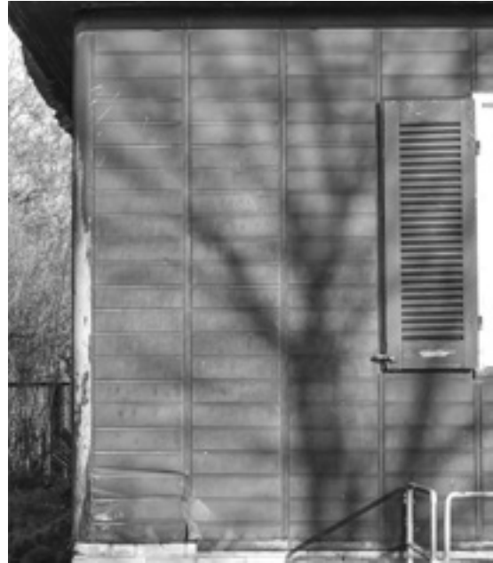
15. Eberswalde/Finow, Vergleich der Kupferhaut und ihrer Befestigung am Haus Kupfercastell (links) und Typ K (rechts), Fotos 2022
