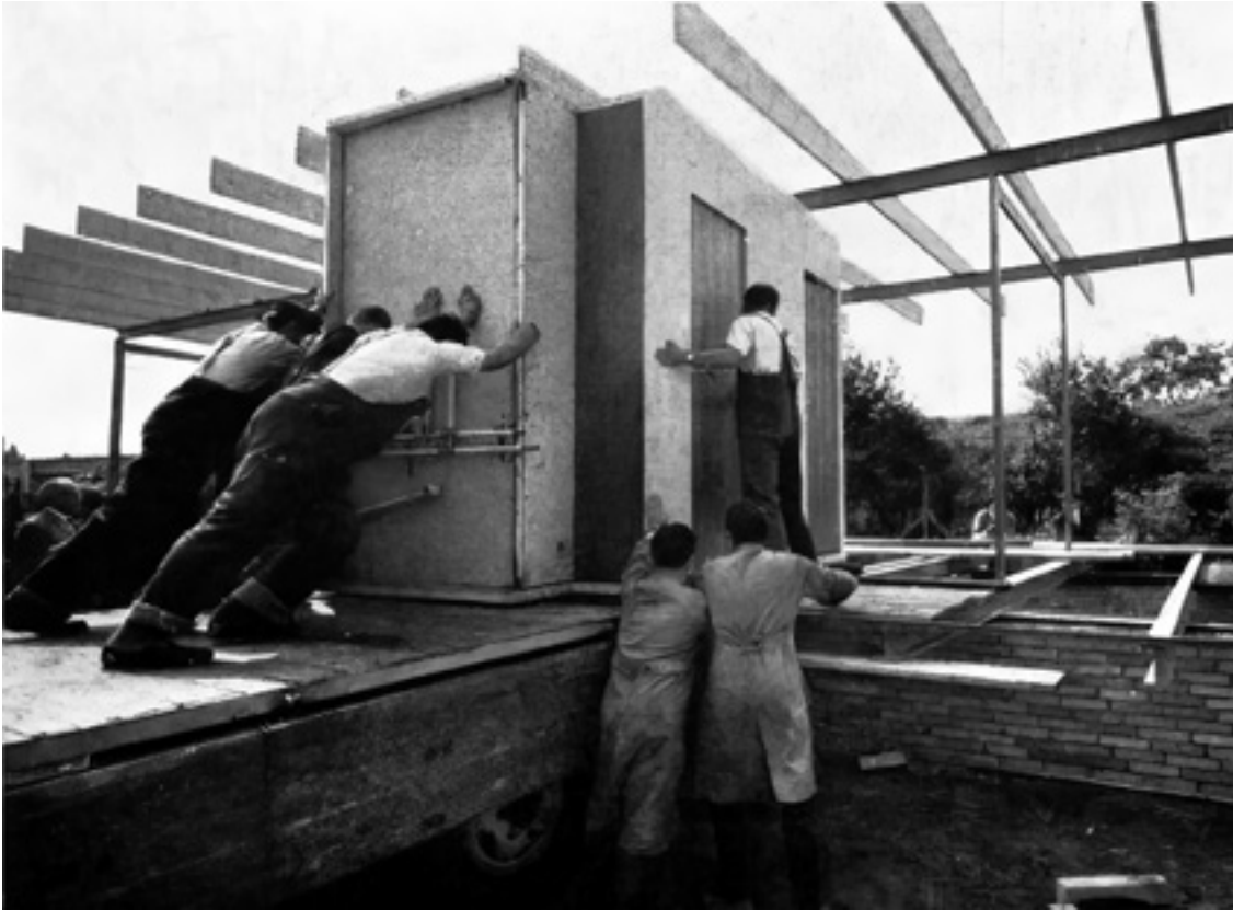
20. Quelle-Fertighaus, Verschieben des Sanitärkerns direkt vom LKW in das Zentralmodul
