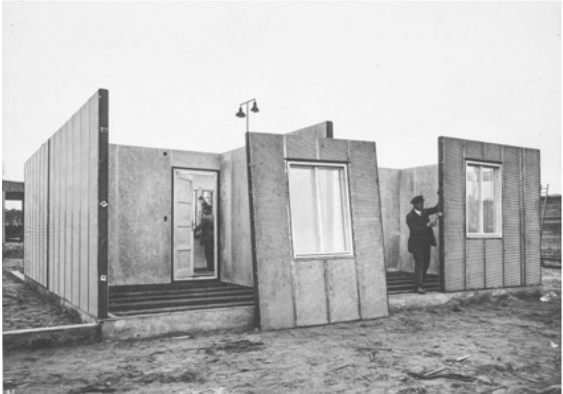
19. Berlin, Aufbau des Kupferhauses Typ S auf der Ausstellung »Das wachsende Haus« in Berlin, Foto 1932
