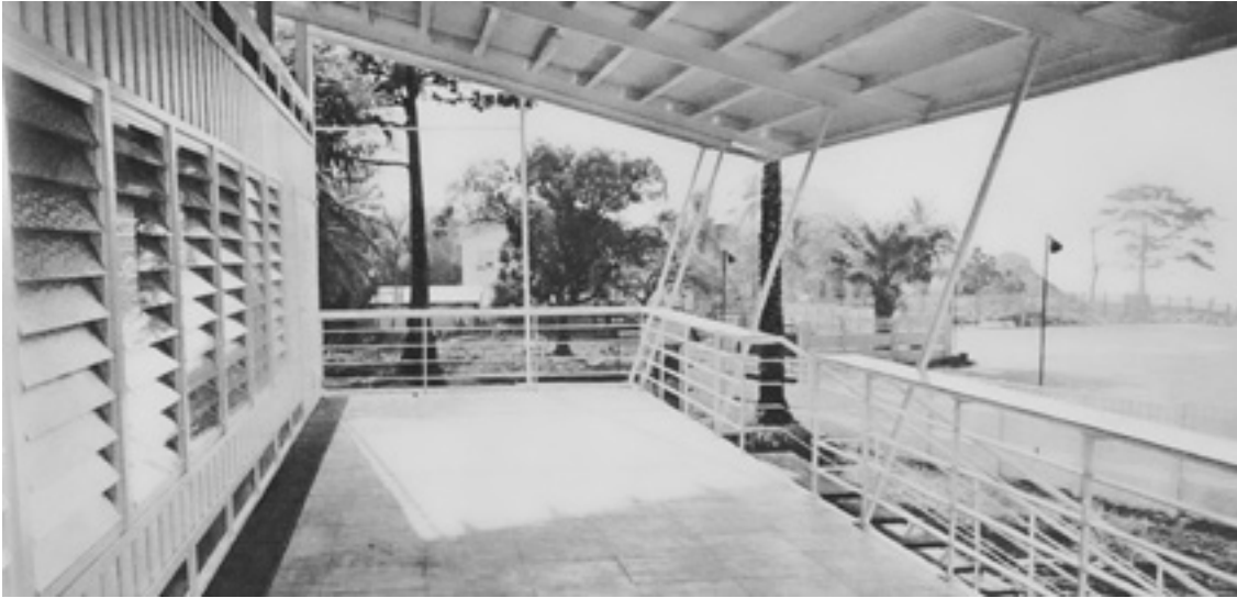
8. Conakry (Guinea): Gästehaus der Regierung von Hoesch und der Donges Stahlbau GmbH, Ansicht, um 1963
