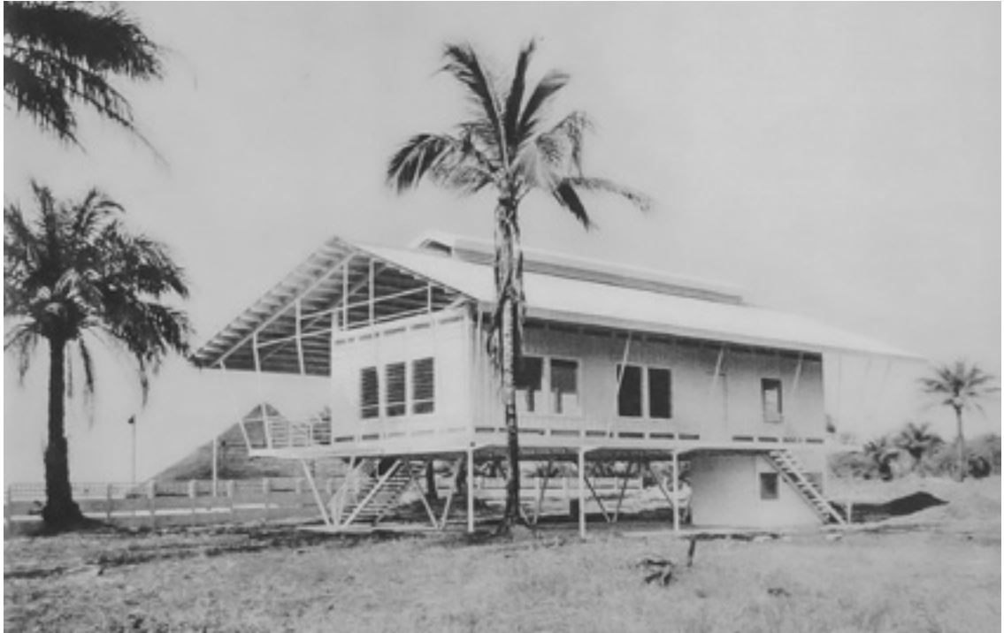
6. Conakry (Guinea): Gästehaus der Regierung von Hoesch und der Donges Stahlbau GmbH, Ansicht, um 1963
