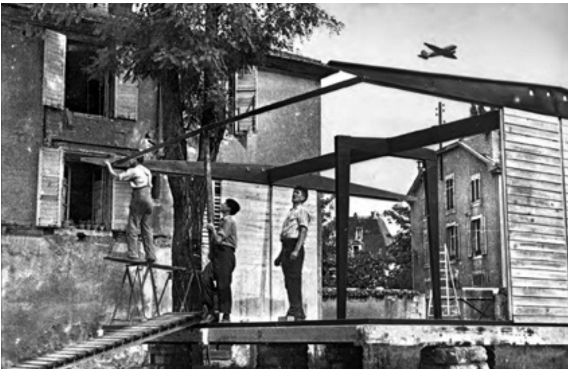
4. Jean Prouvé: Aufbau des von ihm entwickelten 6 m x 6 m großen Pavillons mit Portalrahmenkonstruktion für den Wiederaufbau in Lothringen, 1944/45
