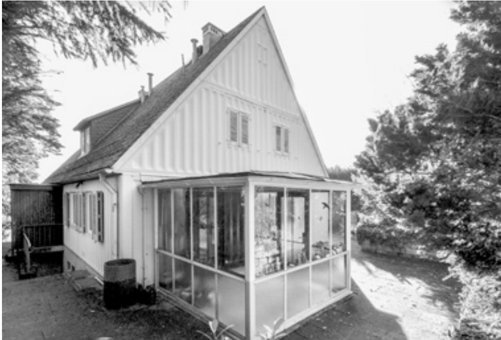
3. Stuttgart-Sillenbuch, M.A.N.-Stahlhaus mit umgebendem Garten des Hanggrundstücks, Foto 2016
