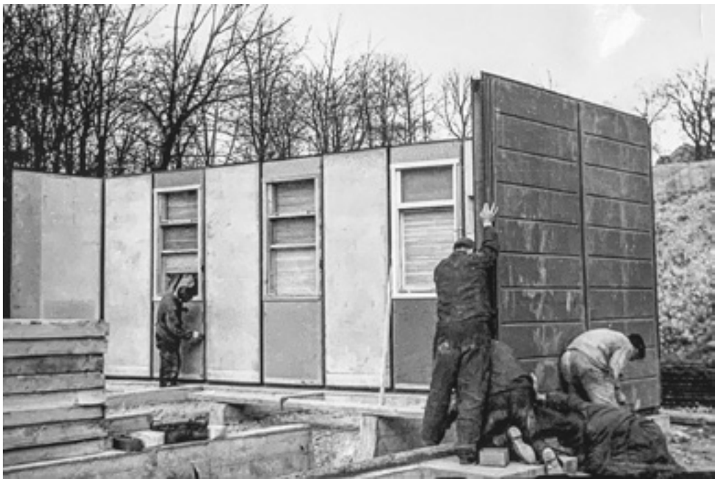
12. Maschinenfabrik Augsburg-Nürnberg (MAN), Aufbauprozess eines M.A.N.-Stahlhauses
