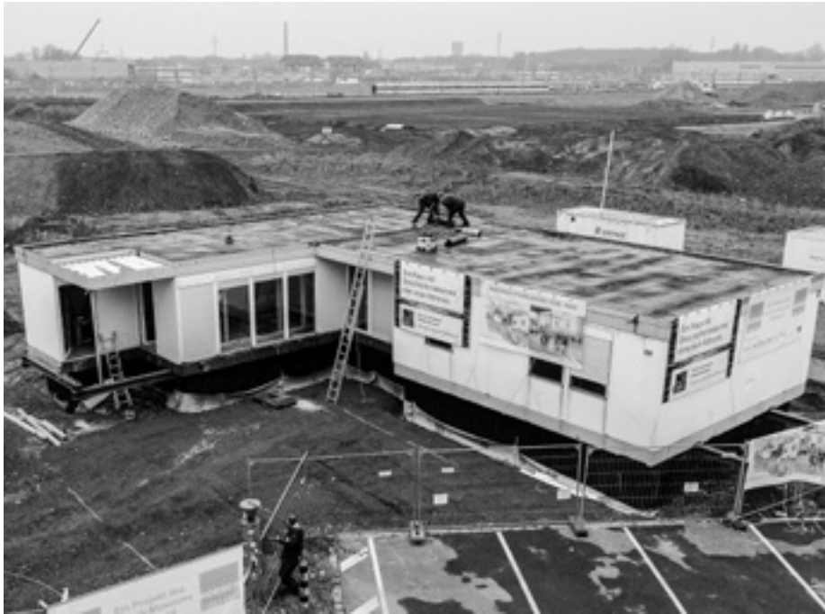
9. Das Hoesch-Stahlhaus L 141 am neuen Standort in Dortmund im Dezember 2022
