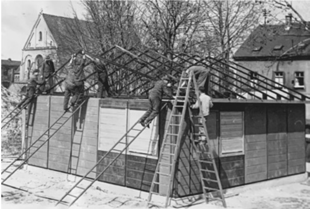
11. Maschinenfabrik Augsburg-Nürnberg (MAN), Aufbauprozess eines M.A.N.-Stahlhauses
