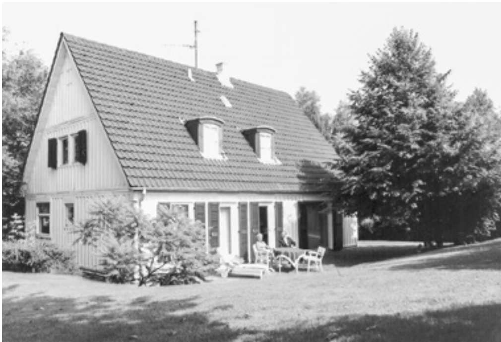
4. Essen-Werden, M.A.N.-Stahlhaus kurz nach der Fertigstellung, Foto 1951
