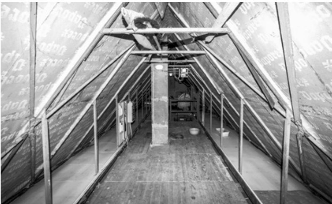
6. Essen-Werden, M.A.N.-Stahlhaus, Blick in den Dachstuhl aus Stahlwinkelprofilen ohne Stoß in den Sparren, Foto 2019
