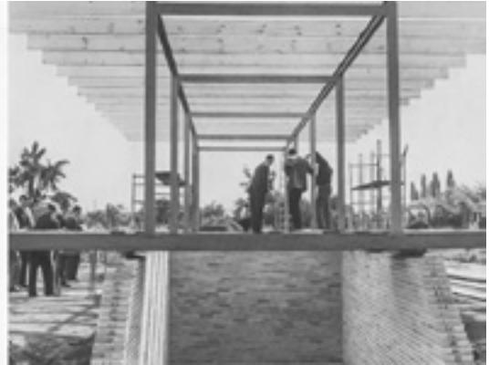
5. Quelle-Fertighaus, schematischer Schnitt und tragende Konstruktion vor dem Ausbau
