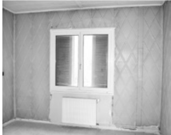
17. Eberswalde/Finow, Kupferhaus Typ K, bei der Sanierung freigelegte Innenbeplankung: links Wohnküche, rechts Schlafzimmer, Foto 2022
