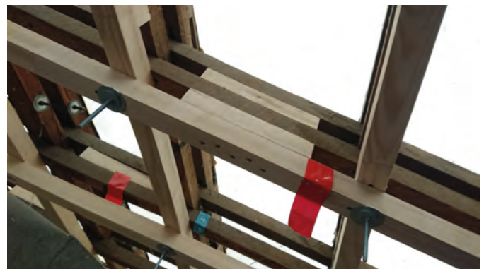
Bild 9 Zusätzliche Schubverbinder koppeln die einzelnen Lagen der Gitterschale (Quelle: Fast + Epp) Additional shear connectors couple the individual layers of the grid shell
