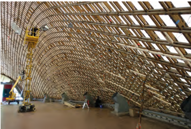
Bild 7 Die Verstärkungslatten wurden in der Testfläche von einer mobilen Arbeitsbühne aus montiert (Quelle: Fast + Epp) The reinforcement laths were installed in the test area from a mobile working platform
