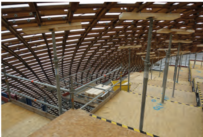
Bild 11 Mithilfe von Schwerlastspriëßen auf der Gerüstplattform wurde das Dach Stück für Stück angehoben (Quelle: Fast + Epp) Heavy-duty jack posts were placed on the scaffold platform to lift the roof step by step
