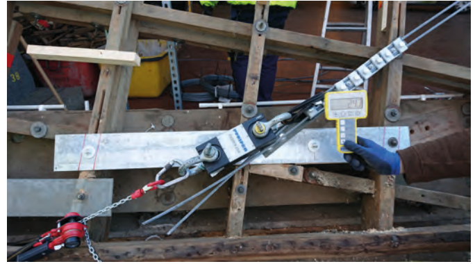
Bild 8 Die Seile und Anschlusspunkte werden getauscht und eine Vorspannkraft aufgebracht (Quelle: Fast + Epp) The cables and end connections are replaced and a pretensioning force is applied
