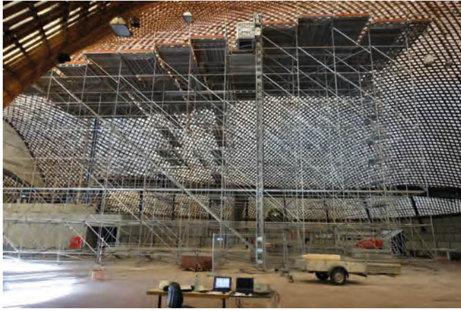
Bild 10 Der Bereich unter der größten Beule wurde vor dem Hochdrücken mit einem Raumgerüst unterstützt (Quelle: Fast + Epp) The area with the largest deformations was supported with a birdcage scaffold before pushing up
