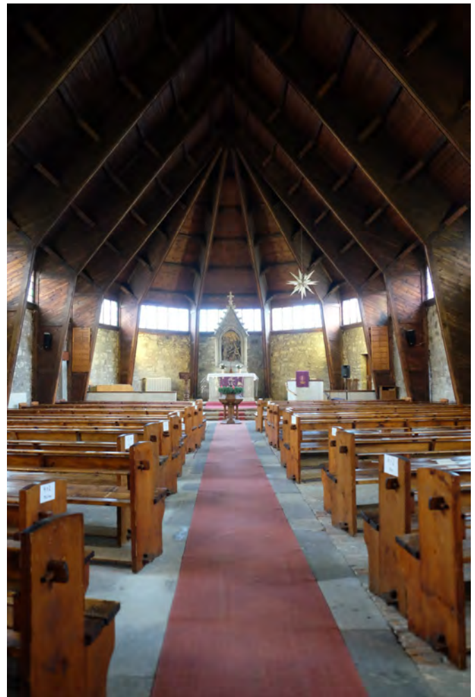
Bild 4 Dresden-Löbtau, Friedenskirche, Bj. 1949, Dreigelenk-Vollwandbinder, Foto 2021 (Quelle: Iris Engelmann/VG Bild) Dresden-Löbtau, Friedenskirche, constr. year 1949, three-hinged frame, solid-walled trusses
