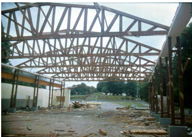
Bild 2 Adorf, Halle während des Abrisses 1978, (Foto: Ostermann/Privatarchiv Erwin Brüne) Adorf, hall during demolition 1978
