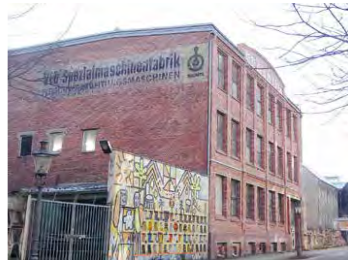
Mit repräsentativer Fassade präsentiert sich die Maschinenfabrik Gebrüder Unger AG in der Lerchenstraße in Chemnitz. Foto: Achim Dresler, 2024
