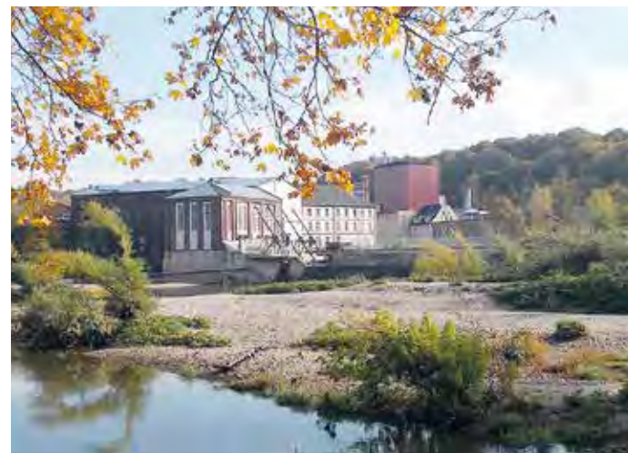
Die Papierfabrik Golzern in Grimma wurde nach dem Hochwasser 2013 stillgelegt. Foto: Jwaller / Wikimedia Commons, 2013
