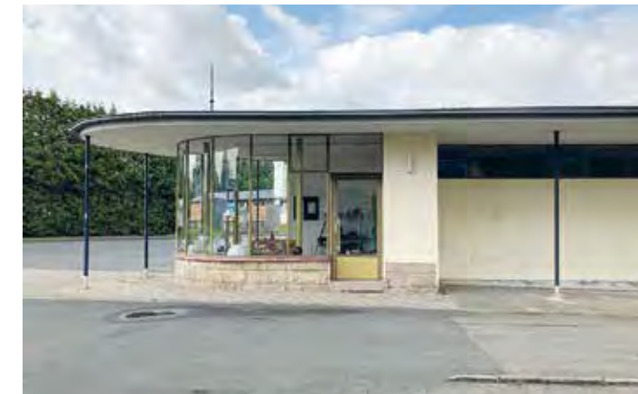
Auch das 1954 erbaute Pförtnerhäuschen prägt den Eingang der Glashütte Süßmuth in Immenhausen. Foto: Anette Mittring / Deutsche Stiftung Denkmalschutz, 2023
