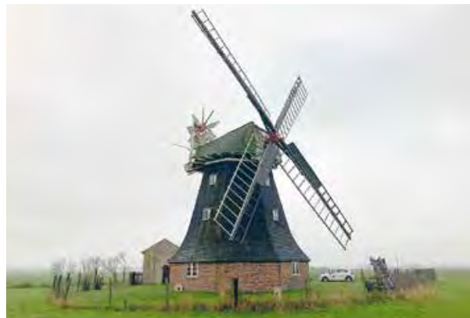
Eine Windmühle wie als Ideal gemalt: der 1881 in Rövershagen erbaute Erdholländer. Foto: Guido Siebert / Deutsche Stiftung Denkmalschutz, 2021
