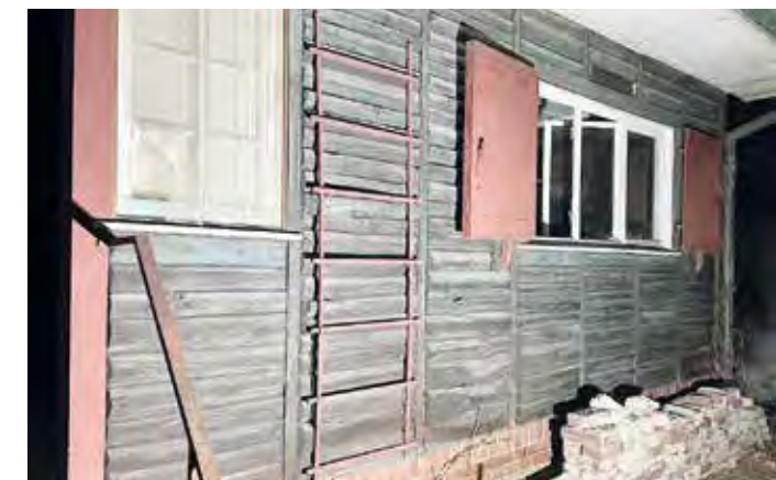
Auf dem gemauerten Keller des Wohnhauses Buchholtz in Grünau wurden Hellerauer Kassetten – seriell hergestellte Holzfertigteile – gesetzt. Foto: Alexander Güter / Deutsche Stiftung Denkmalschutz, 2023
