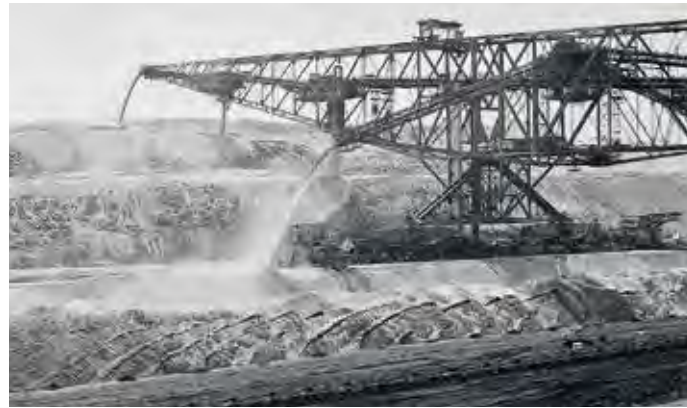
Die Förderbrücke F60 in Jänschwalde wirft den zuvor auf der anderen Seite des Tagebaus geförderten Abraum von mehreren Bändern ab. Foto: Sven Bardua, 1999
