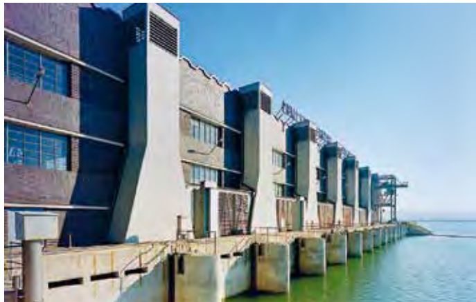
Das seit 1930 betriebene Pumpspeicherkraftwerk Niederwartha wurde bis 1960 in alter Formensprache ergänzt. Foto: Christian Bedeschinski
