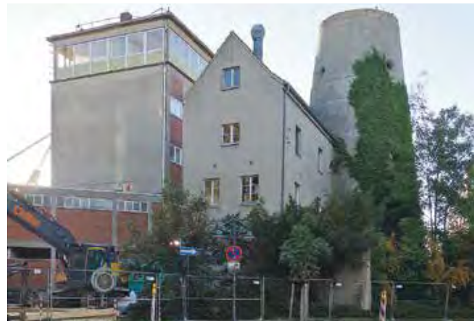
An der Bahnhofstraße präsentierte sich die Mühle Münstermann in Ahlen (von links) mit einem Lagergebäude aus den 1960er Jahren, dem Mühlengebäude von etwa 1910 und dem Stumpf der Windmühle. Foto: Alexander Calvelli, 2023
