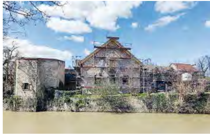
Die Gebäude im Hafen von Marktsteft werden saniert; erhalten ist auch der steinerne Unterbau eines Krans (links). Foto: Peter Schabe / Deutsche Stiftung Denkmalschutz, 2023
