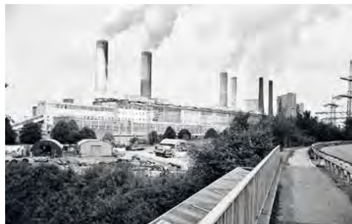
Der zentrale Komplex des Kraftwerks Frimmersdorf ist 550 Meter lang und 52 Meter hoch. Foto: Sven Bardua, 1990
