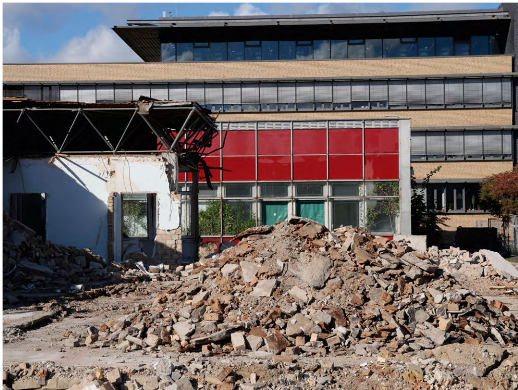
4 Abriss des Typenbaues R 300-Großrechnerge- bäude der Universität Greifswald
